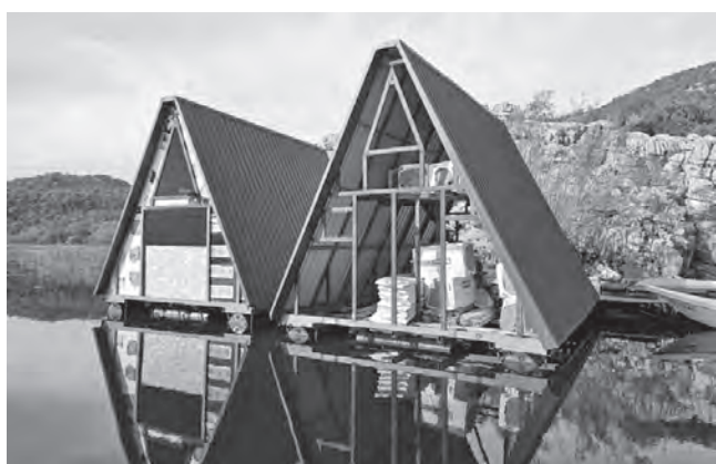
PROVJERIĆE IMAJU LI DOZVOLU: Plutajući objekat na Skadarskom jezeru
